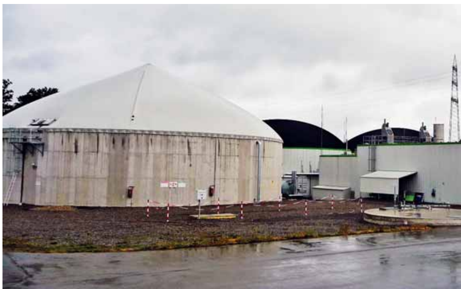
Foto 1 L'impianto di Mühlacker immette in rete dai 480 ai 520 m 3 /ora di biometano e soddisfa il fabbisogno di calore di circa 2.000 utenze
