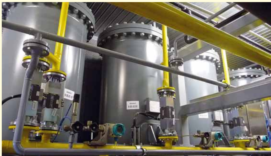
Foto B Le quattro torrette interne di purificazione del biogas in biometano
